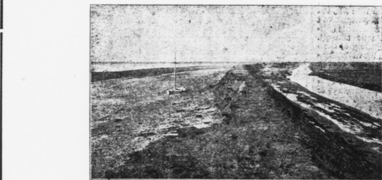
Fig. 12. Parti af Diget Nord for Vester Vedsted Sluse efter Stormfloden i November 1911. Digets Græsstorvbeklædning var dels ikke sammentrøet, dels manglede den, da Stormfloden indtrådte.
